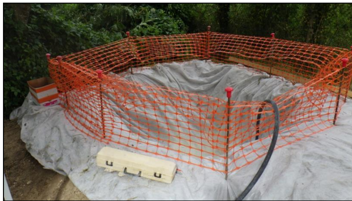
Figure 9 : Ligne 325 000 - Exemple d'un bassin de décantation provisoire pour les eaux d'exhaure de batardeaux
