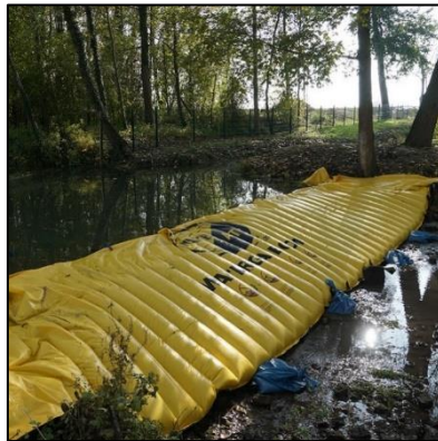
Figure 8 : Ligne 325 000 – Exemple de batardeaux de type Watergate
